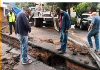
Personal de la Comisión del Agua del Estado de México (CAEM) reparó una fuga de agua potable en la infraestructura hidráulica provocada por una empresa privada que realizaba trabajos en la tubería del municipio de Atizapán de Zaragoza.
